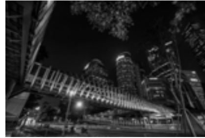
Yuri Nainggolan Jembatan Penyeberangan SEFTI Bandung
