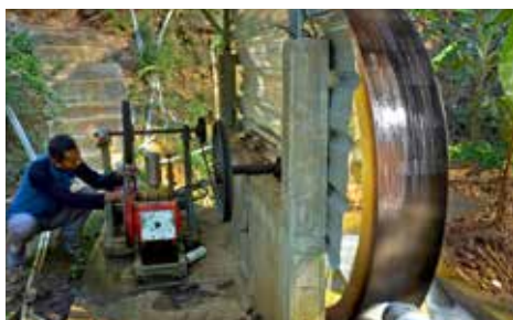
Indonesia-Arif Widodo Al Azis-kincir energi
