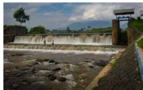
Indonesia-Joni Parlindungan Manurung-Ciherang Dam
